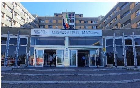
Ingresso principale del primo lotto
